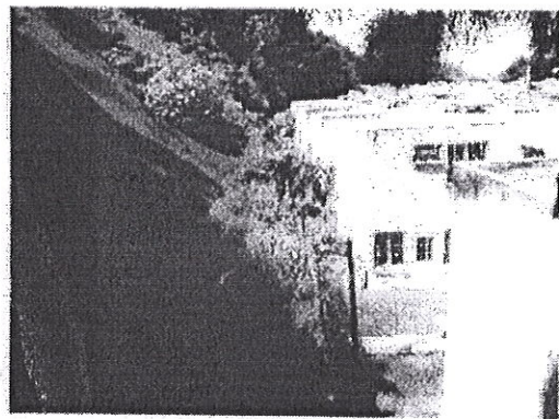
Imágenes 15 y 16. En las fotografías se aprecia que no existe una separación adecuada para amortiguamiento entre el pie de la ladera y las viviendas del sector mencionado.
